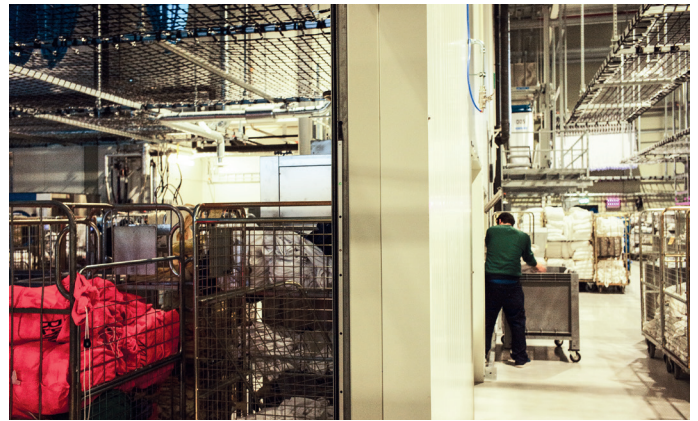
Denne sandwichveggen er bygget som skille mellom skitten sone til venstre og ren sone til høyre.
